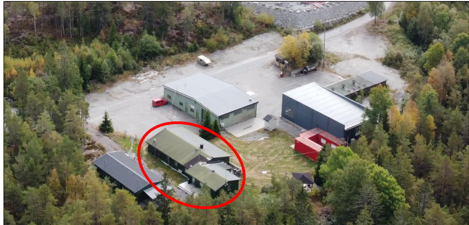
Figur 22: Flyfoto av området ved beredskapsbygget. Kilde: finn.no.
