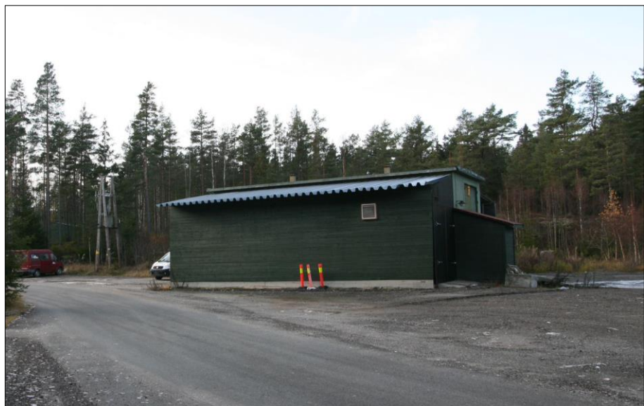
Figur 19: Bilde av Arbeidshuset 2021. Kilde: COWI AS.
