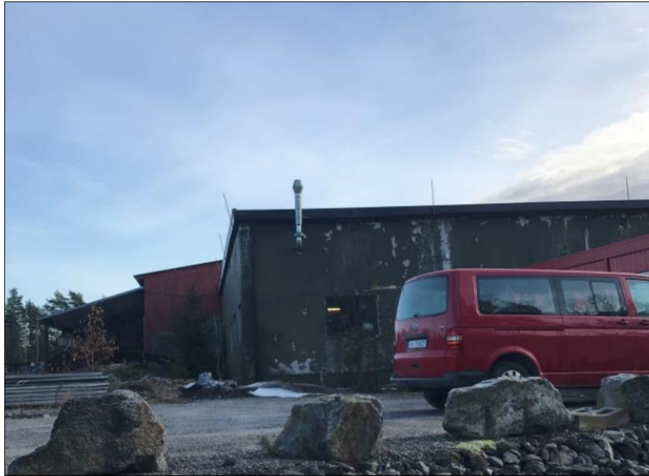
Figur 59: Bilde av magasinet i retning øst - fra 2021. Kilde: COWI AS
