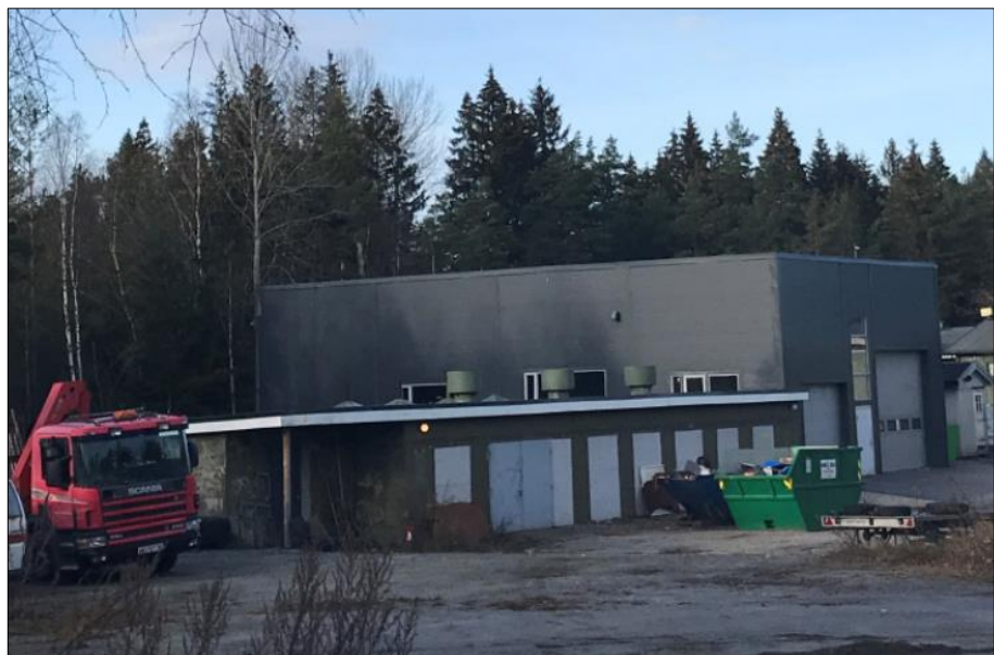
Figur 28: Bilde av generatorbygg 2021. Kilde: COWI AS.
