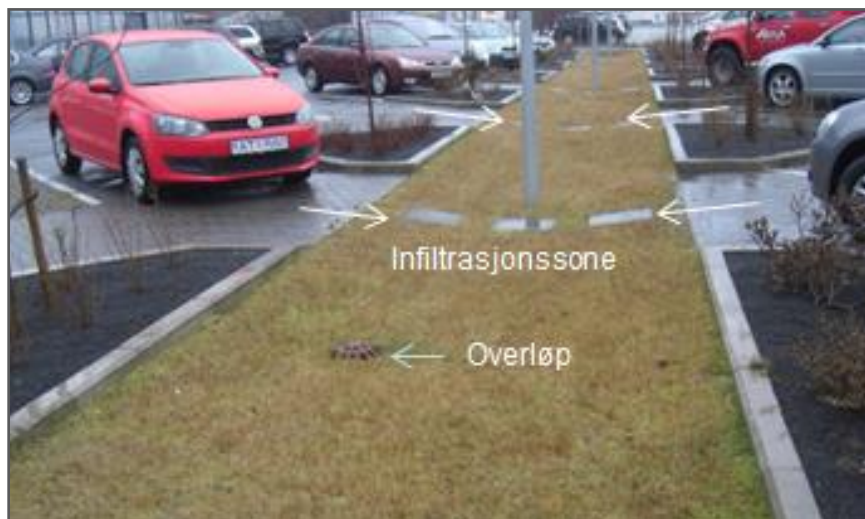
Figur 6 Eksempel på overvannsavrenning fra parkeringsarealer til grønne infiltrasjonssoner. Tiltaket bidrar til fordrøyning og rensing av overvannet.
