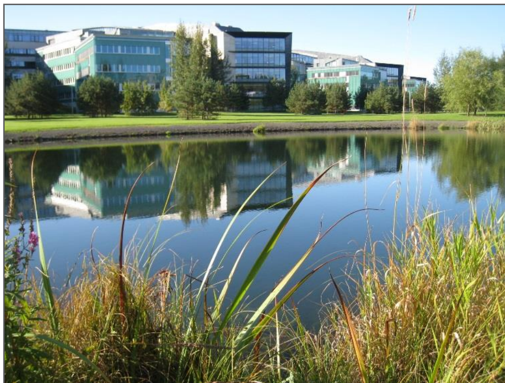
Figur 9 Eksempel på vannspeil som estetisk og fordrøyende tiltak i et næringsområde (Fornebu i Bærum kommune). Vannspeilet tilføres kun takvann og all transport av vann skjer med gravitasjon.
