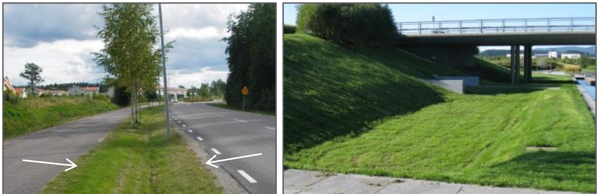
Figur 4 Eksempler på infiltrasjon av overvann fra trafikkerte arealer (veier og plasser). Infiltrasjon langs vei til venstre og sentral løsning for infiltrasjon av oppsamlet veivann til høyre. Tiltaket bidrar til fordrøyning og rensing av overvannet.
