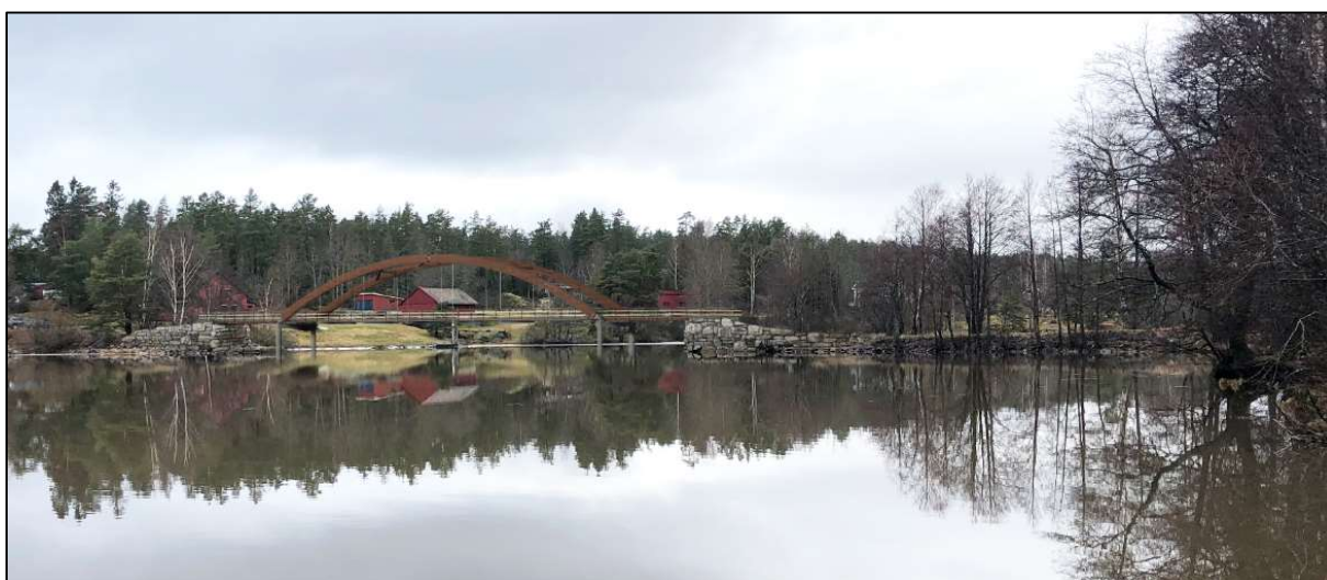
Figur 5-8: Alternativ 2. Kort bru med oppmurte landkar på dagens landkar og tilløpsfyllinger. Kilde: Multiconsult
