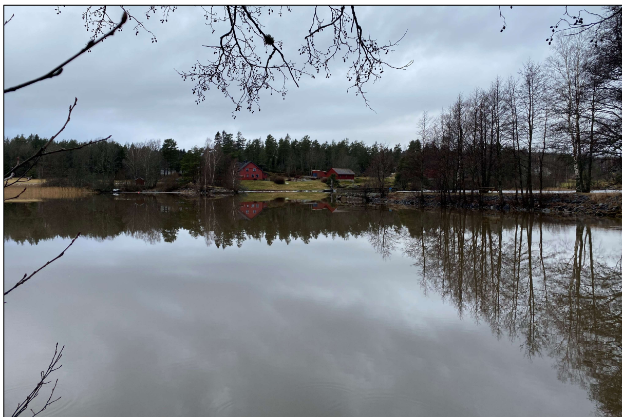
Figur 4-14: Tilløpsfyllingen med vegetasjon skaper en innramming av landskapsrommet sør for brustedet, samt en alléeffekt både sett fra avstand og oppe fra fyllingen. Kilde: Multiconsult
