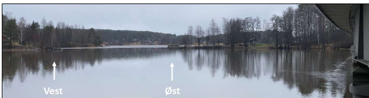
Figur 5-2: Landkarene til gamle Rødsund bru sett fra sør, ved nye Rødsund bru. Kilde: Multiconsult
