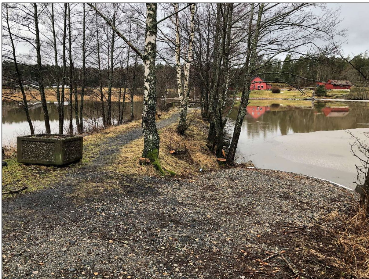
Figur 5-5: Landkar øst, sett mot vest. I bakgrunnen det SEFRAK-registrerte huset på østsiden (det røde lengst mot venstre). Landkar øst er ikke avsatt til hensynssone bevaring i reguleringsplan, men til del av hensynssone friluftsliv i kommunalt overordnet planverk (kommuneplanens arealdel Våler kommune). Kilde: Multiconsult
