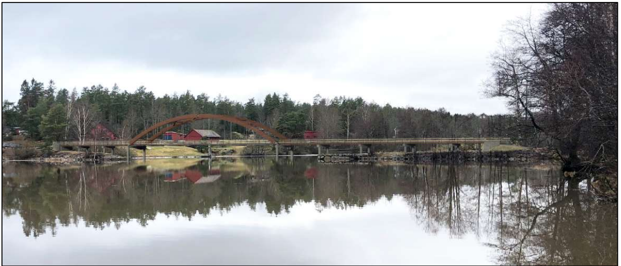
Figur 3-8: Alternativ 3. Lang bru på søyler oppå dagens landkar og tilløpsfyllinger. Kilde: Multiconsult
