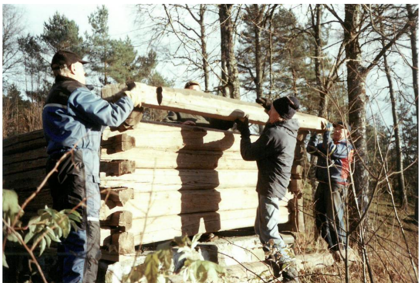
Kjona på Bergtunet under gjenreising. Foto: Hans Magnussen
